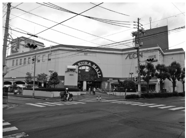
老朽化で再開発計画が進む松本カタクラモール
