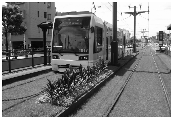
8.9kmに渡って軌道敷地に芝生を敷いた市電の運行状況
